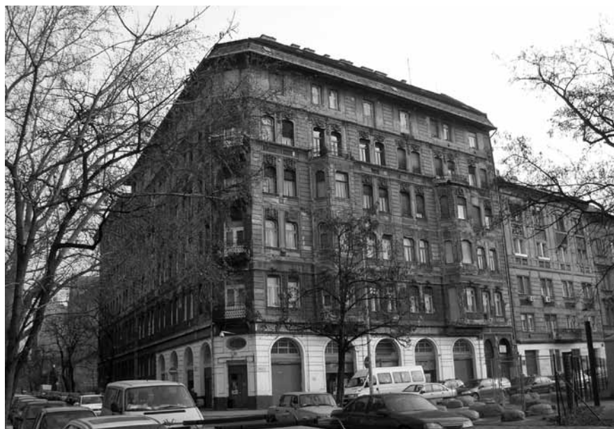
Budapest, immeuble en réhabilitation. Photo : D.R.
